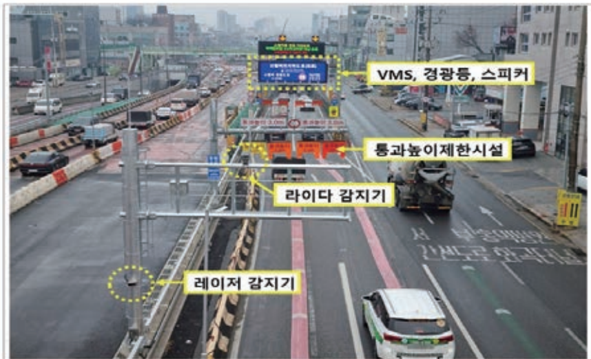
▲ 스마트 진입제한 안내시스템 현장 설치 현황
