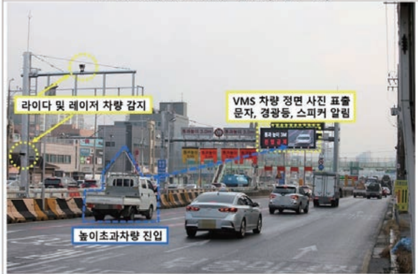
▲ 스마트 진입제한 안내시스템 현장 설치 현황
